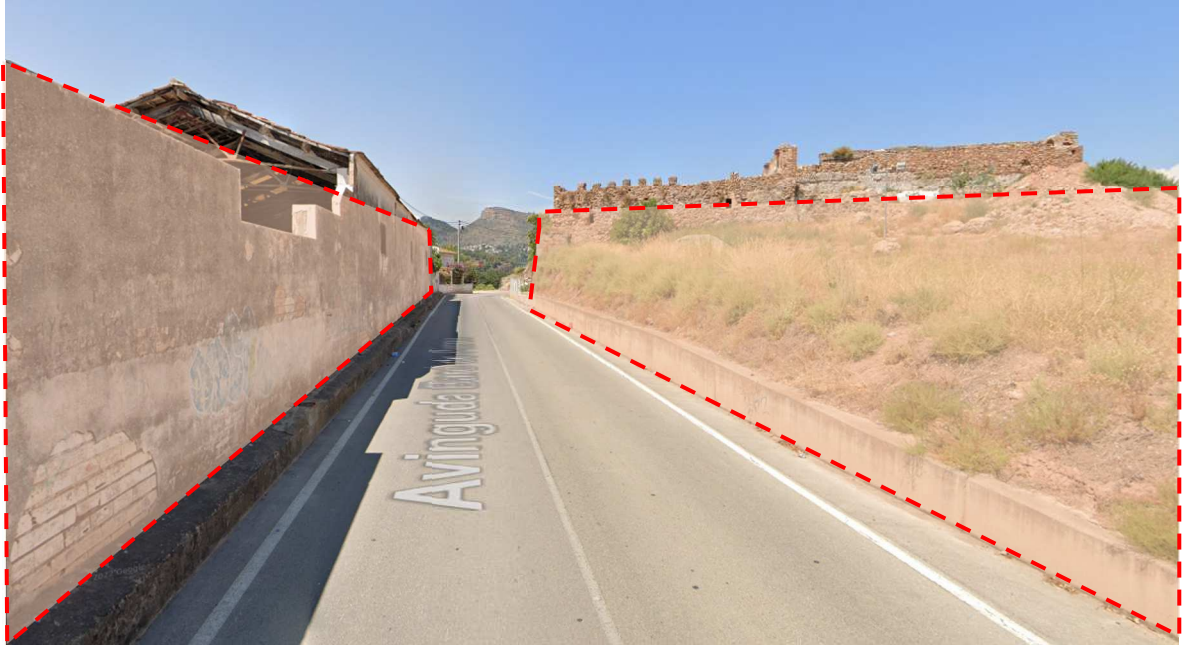
Vista 3: El Castillo de Petrés en el margen derecho con bancal y un edificio en ruinas en el margen izquierdo.
